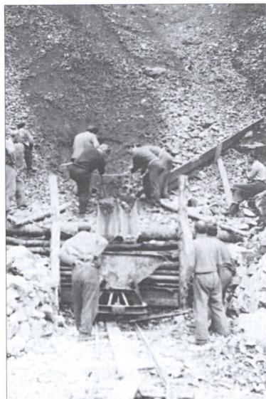
Obr. 4. Krasový prameň Vízavat. Nakladanie sutiny priamo zo svahu strže pomocou rozpoltenej rúry do banského vozíka typu kačák
