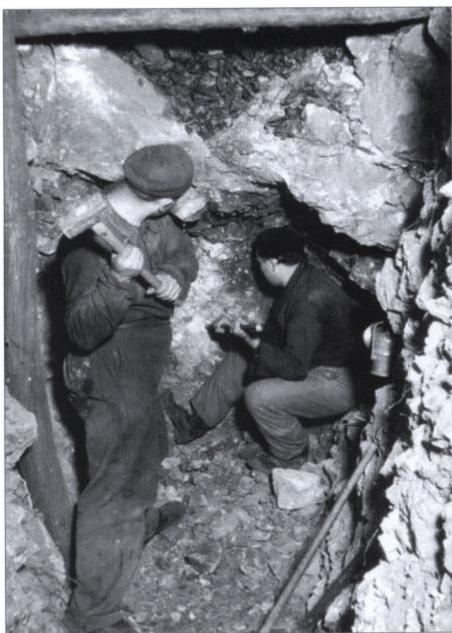
Obr. 3. Ručné vŕtanie pri razení umelého vchodu Novej Brzotínskej jaskyne. Foto: V. Rozložník
